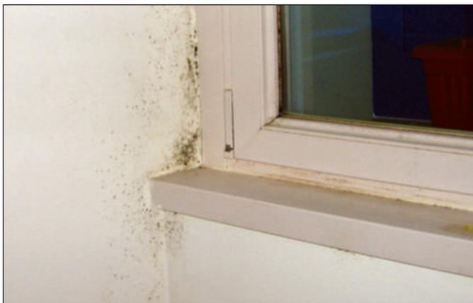
Esempio di ponte termico morfologico in prossimità del contorno telaio finestra.
