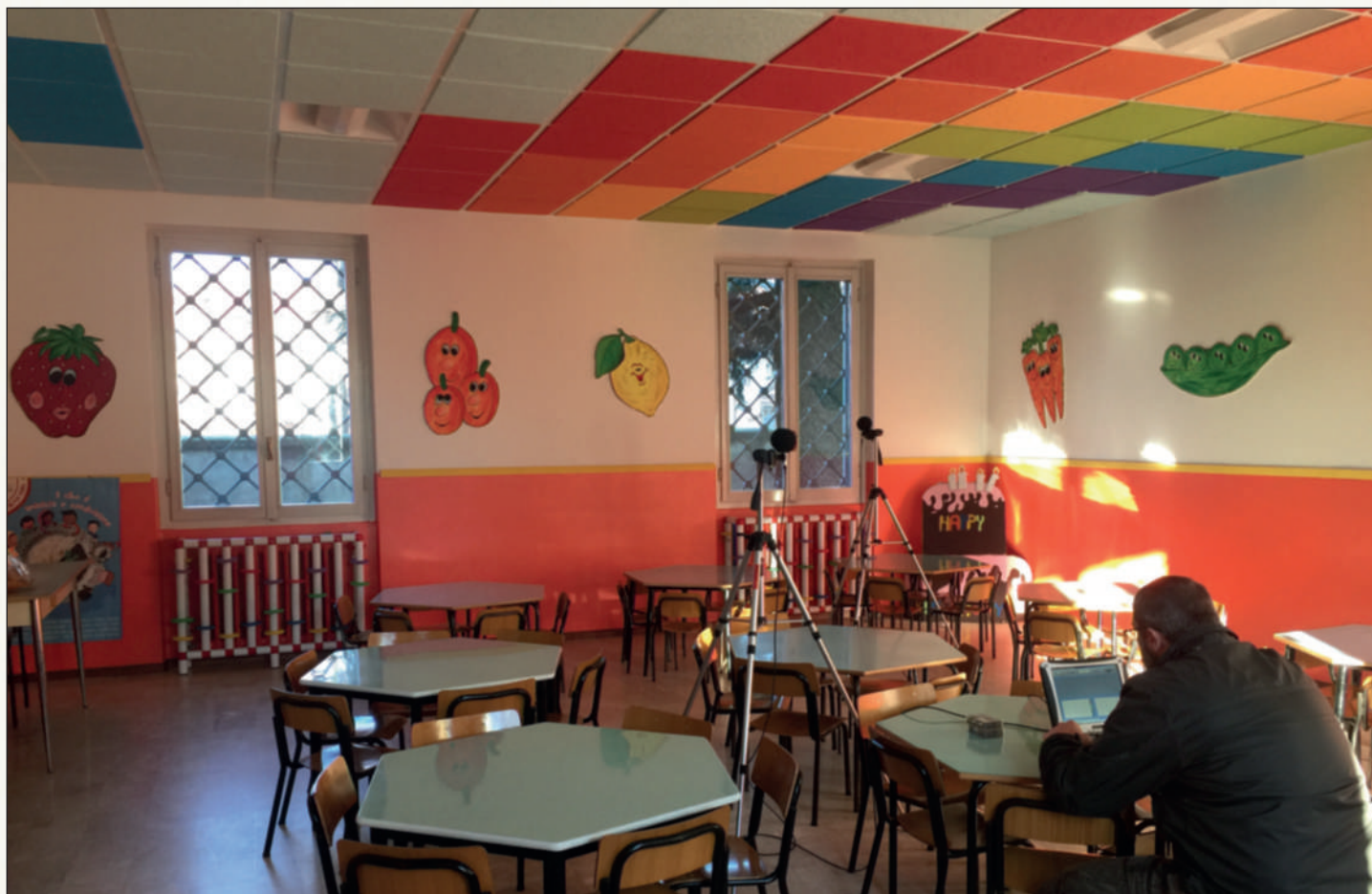
Nella mensa il controsoffitto in sughero preformato e pretinteggiato Kontro risponde a caratteristiche acustiche, termiche e cromatiche. Collaudo acustico eseguito dallo staff tecnico Coverd nella Scuola Materna "Giuseppina Gneccchi" di Verderio (LC)
