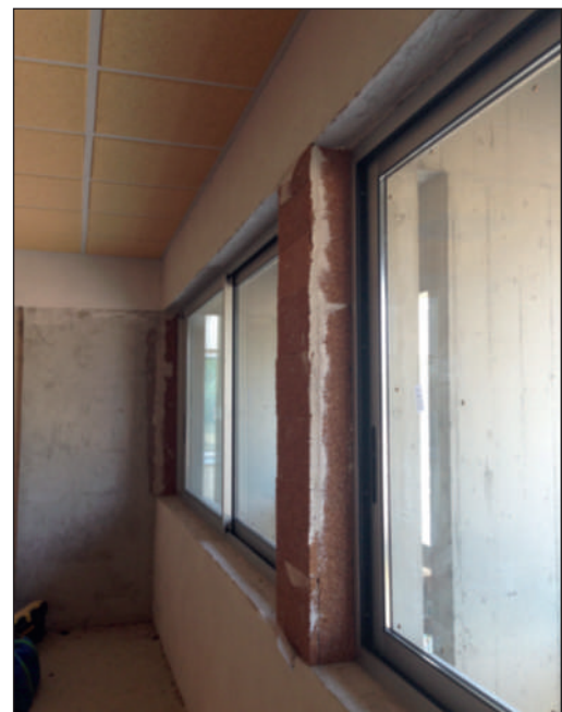
Particolare dell'applicazione dei pannelli in sughero biondo naturale supkompatto SoKoVerd.LV a grana fine 2/3mm sotto il davanzale, spalle finestre e cassonetti per eliminare i ponti termici.
