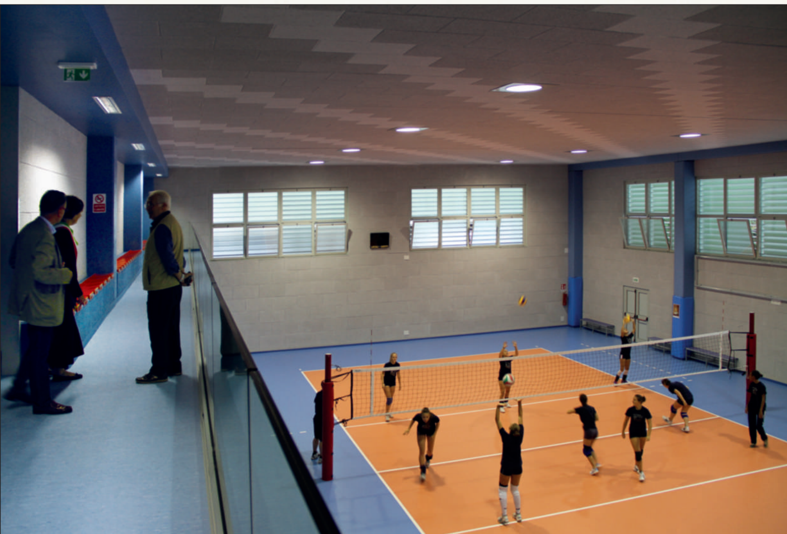
Correzione acustica, risparmio energetico ed estetica personalizzata con il rivestimento in sughero preformato e pretinteggiato SoKoVerd.C1 alle pareti e soffitto. Palestra di Cinisello Balsamo (MI) Progetto: studio Archè Bresso (MI)
