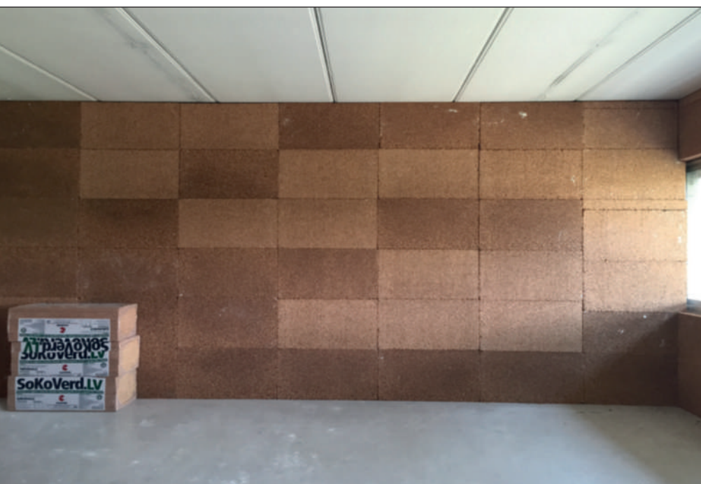
Rivestimento a cappotto interno delle pareti, con applicazione di pannelli in sughero biondo superkompatto SoKoVerd.LV e SoKoVerd.XL mediante adesivo a presa rapida PraKov. Al di sopra dei pannelli in sughero, verrà eseguito l'intonaco minerale traspirante KoMalt.G con affogata la rete KoRet, atto a ricevere la finitura finale.
